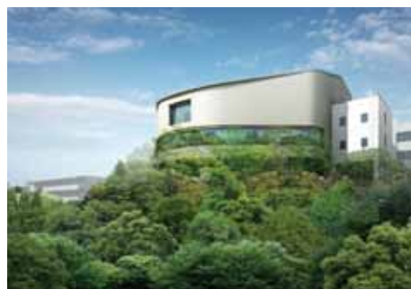
東側(蝮谷側)からの外観
